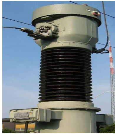
चित्र-9.13B करंट ट्रांसफार्मर
