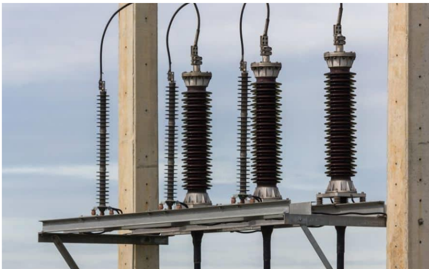
चित्र-9.15 लाइटनिंग अरेस्टर (पतला इंसुलेटर)
