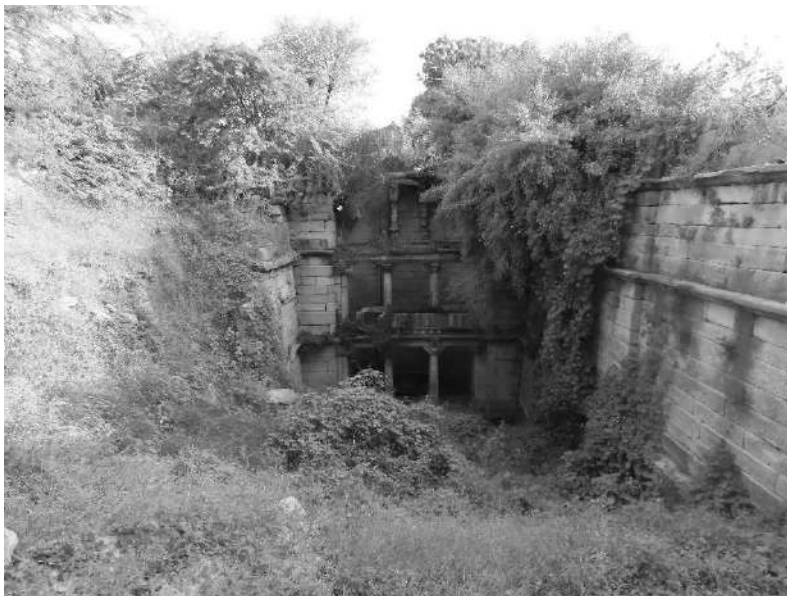
Nadol-Dua Baodi- collapsed side wall
