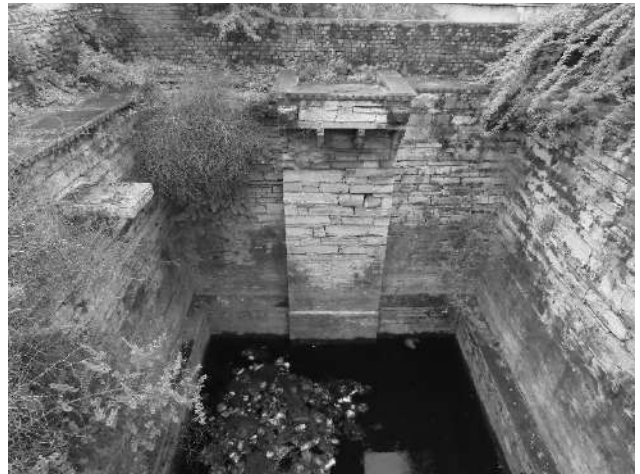
Lakheri-Tamboliyon ki Baodi-well shaft
