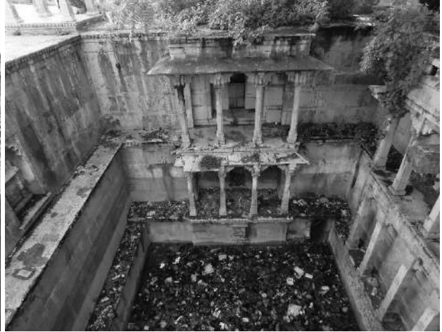
Begun-Neelkanth mahadev ki Baodi-well shaft
